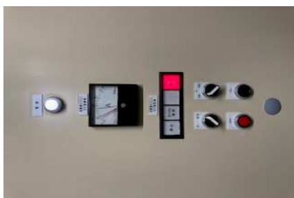
【写真3】 排気ファン試運転 電流値34A ( 34A \times 200V \times 1.7 = 11.5kw ) で、 11kwの定格運転であることを確認。 (通気障害時は排気が逆流し、電流15A程度) 試運転後、自動運転設定 (AM7~9時運転)
