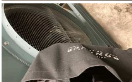
【写真2】 排気ファン試運転 トートバックがファンに吸い込まれている状況 正常に排気運転している
