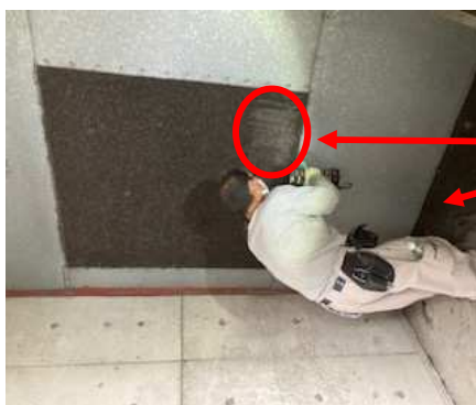
【写真2】 換気ダクト口の金網と塵芥状況 金網の目は1cm程度で塵芥により完全閉塞している 部分的に削り落とし、足元は削った塵芥 換気ガラリ側にも網があり、防虫の必要性はないと 判断して、網を取り外して運転した。
