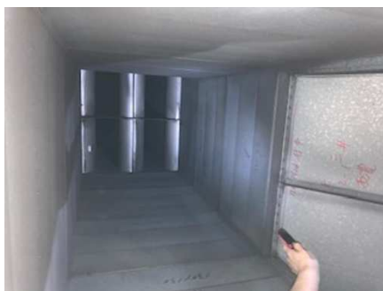
【写真1】 B1ダクト一部解体により消音器部分を観察 消音器のサイズは3m × 1.5m × 1.3m 写真で光って見える部分（約20cm幅）は消音器 黒く見える部分（約50cm幅）は空洞で障害無し
